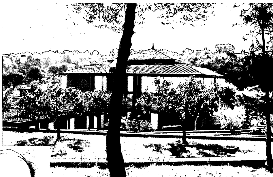
L'edifici del Seminari està ubicat en un antic monestir de clausura.
