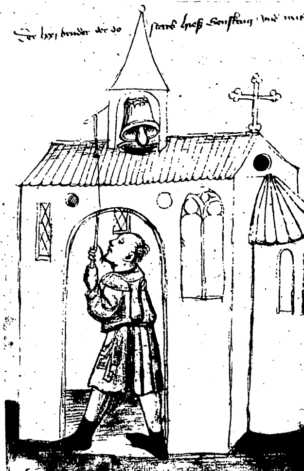
L'església i la campana han estat associades des de fa molts anys, tal com posa en evidència aquest relleu medieval.
