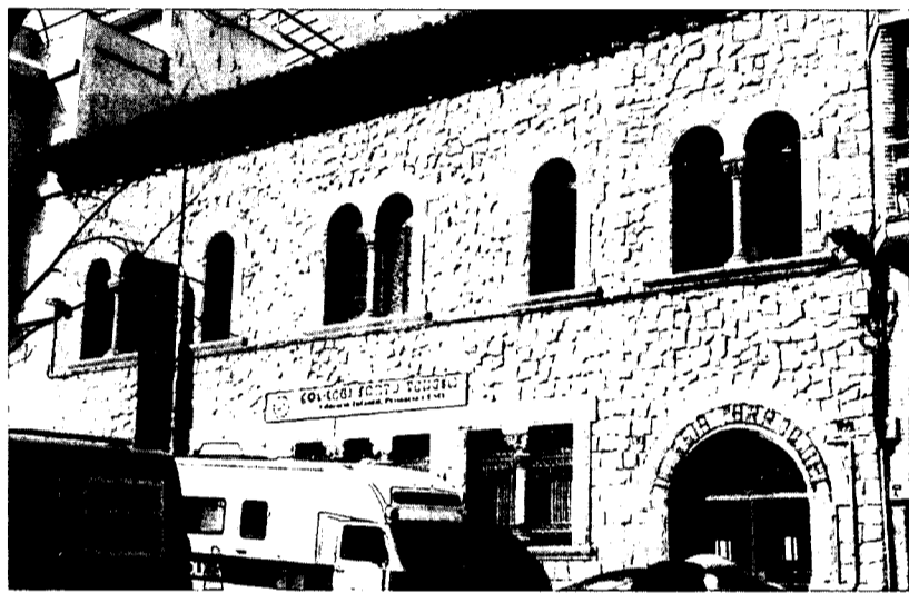
L'església de Santa Teresa de Jesús, entre els edificis afectats per l'ensorrament al Carmel.
