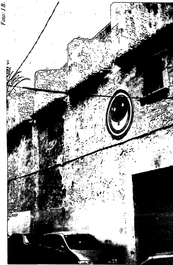
Una de les façanes de l'antiga església.
