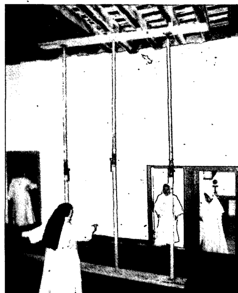
Les dependències estan apuntalades.
