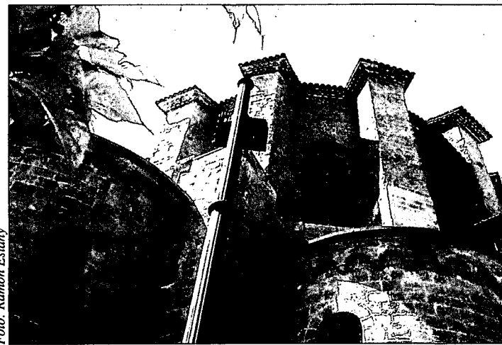
Es va comprovar el funcionament dels focus instal·lats de forma provisional.
