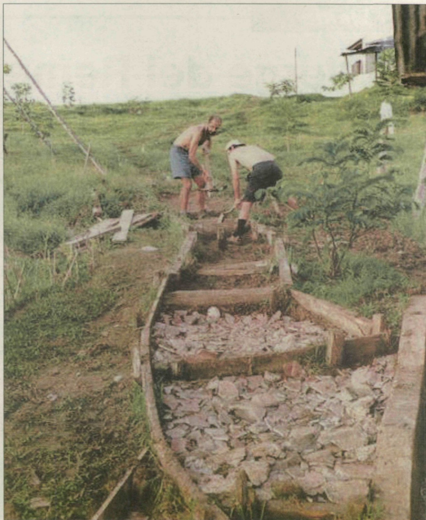
Una de les feines a la qual han dedicat més temps és la construcció d'un camí des de l'institut fins a la pila d'aigua.
