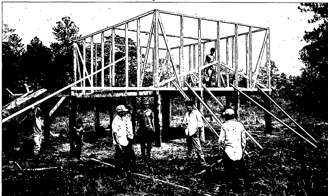
Construcció d'un habitatge a la comunitat de Santa Isabel, a la regió autònoma de l'Atlàntic Nord (Nicaragua).
