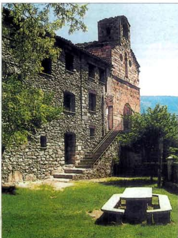
Façana del santuari i casa de l'ermità.
