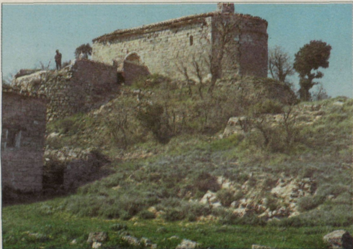
Les esquerdes a l'absis i la inestabilitat del mur de contenció ja es feien presents fa alguns anys.
