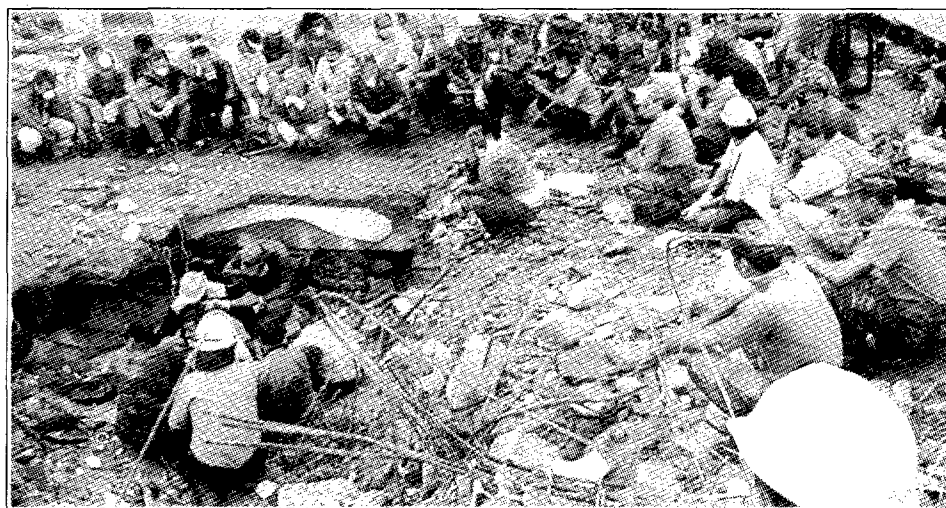
Equips de rescat busquen supervivents entre les runes d'un edifici.
