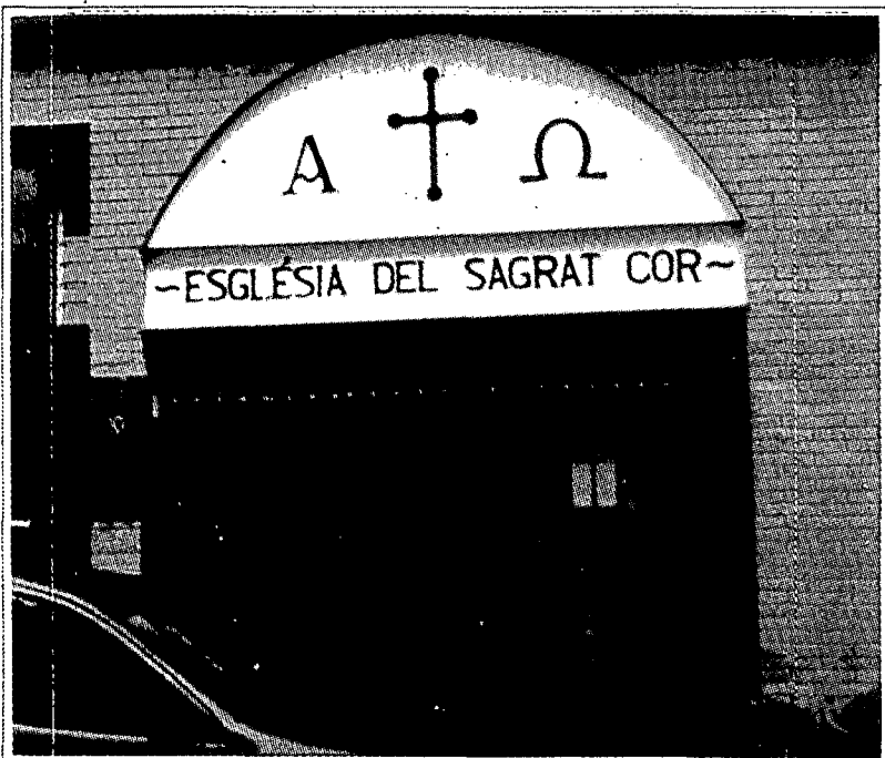
Portalada d'entrada de la nova església de Mataró
