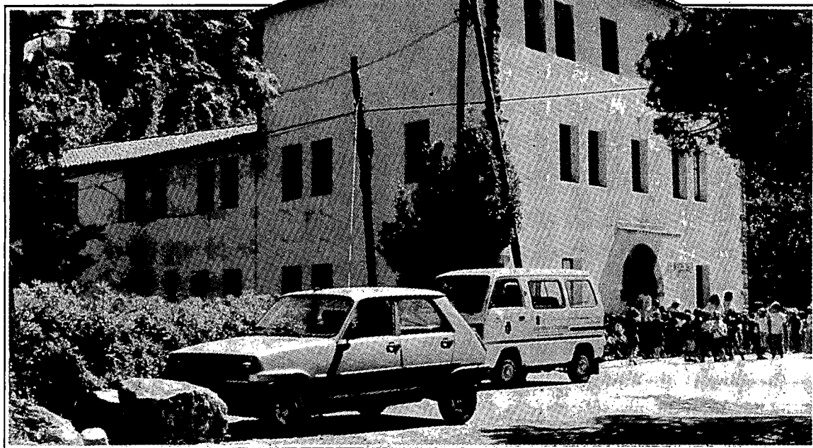
Façana de la casa de colònies de Penyafort, a Pontons
