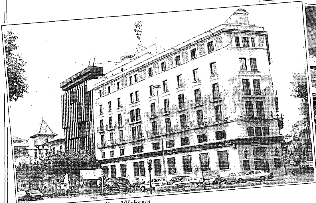
Edifici central de Caixa Penedès a Vilafranca
