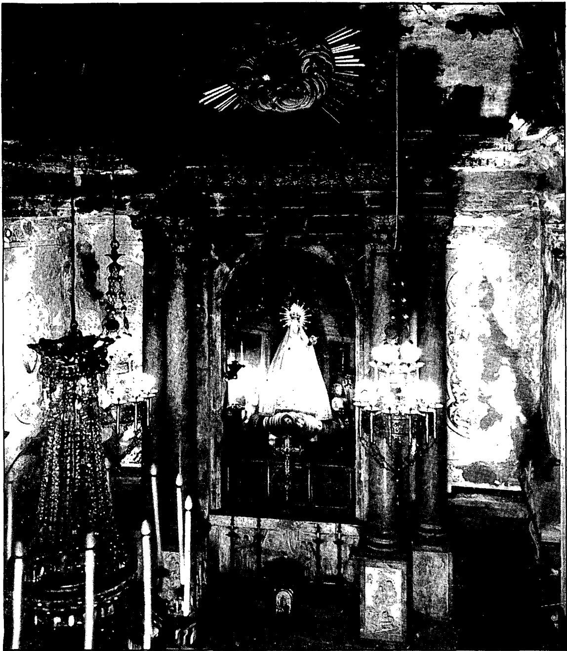
La humitat va deteriorar molt la capella.
