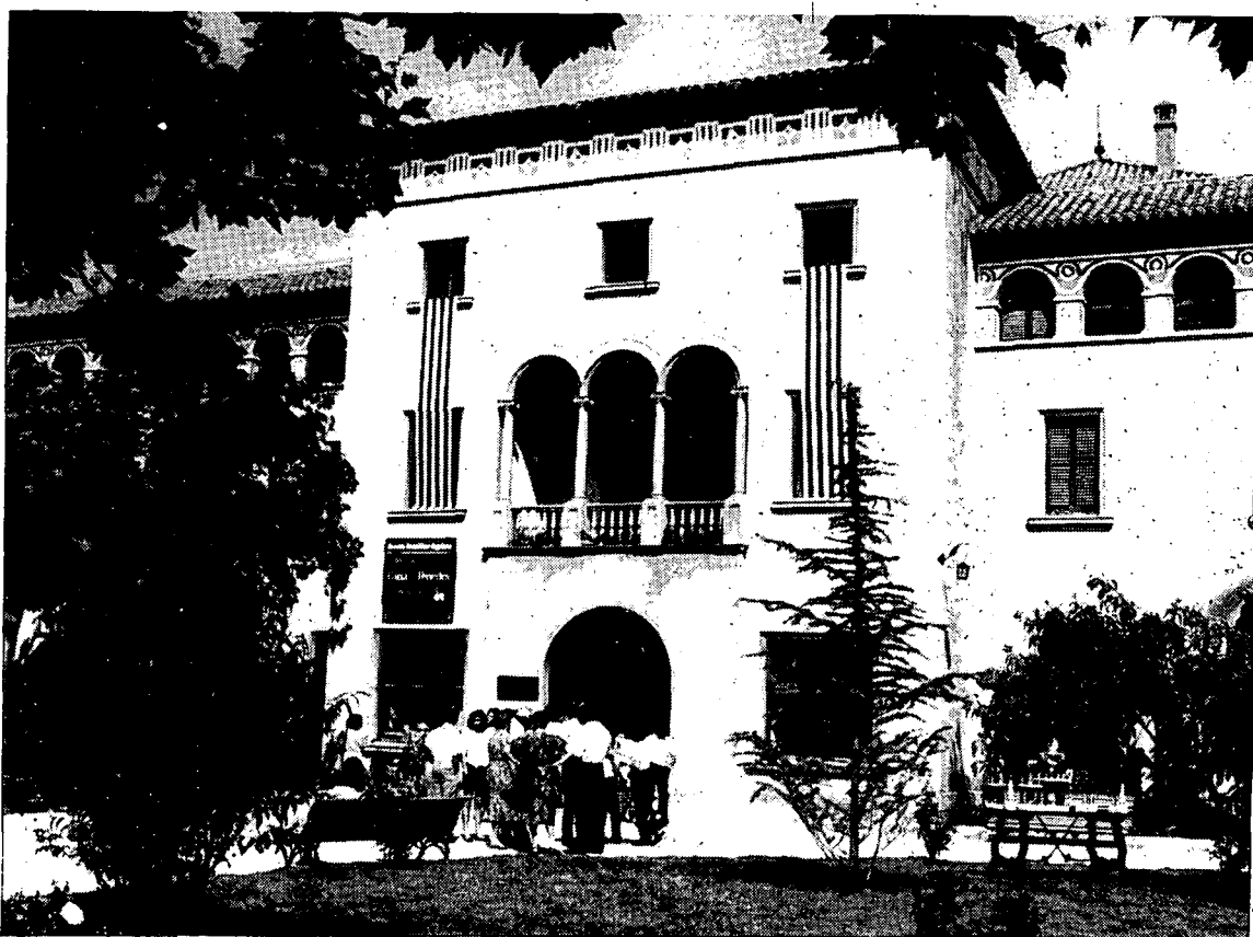
Can Gallart, a l'Arboç del Penedès, centre de formació de l'obra social de la Caixa del Penedès.
