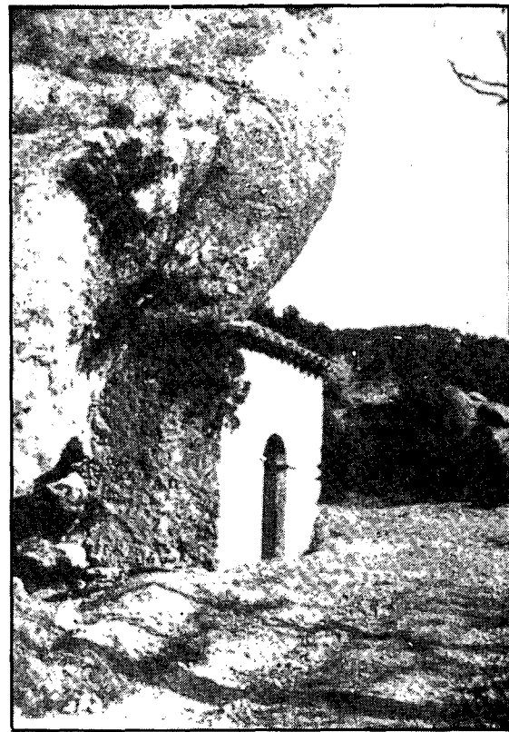
Vista exterior de l'ermita.
