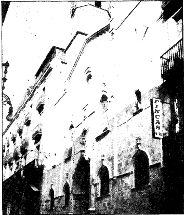
Vista de la façana
