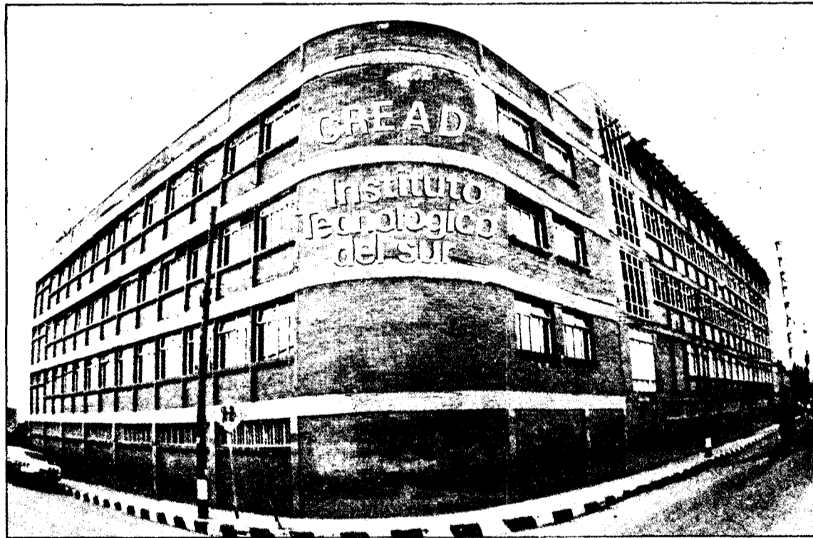
Aquest magnífic edifici, obra de la Fe de mossèn Bonjorn, serà la seu de la nova universitat a distància.
