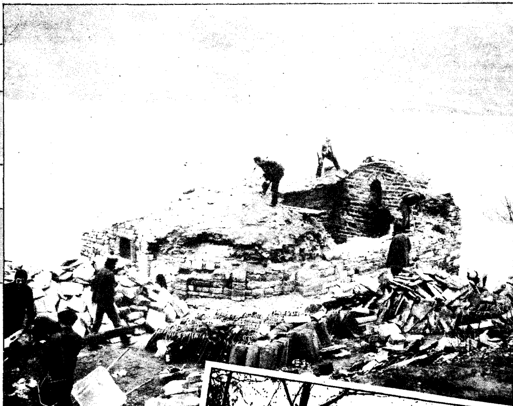
El trasllat no fou senzill per causa de la pujada de les aigües.
