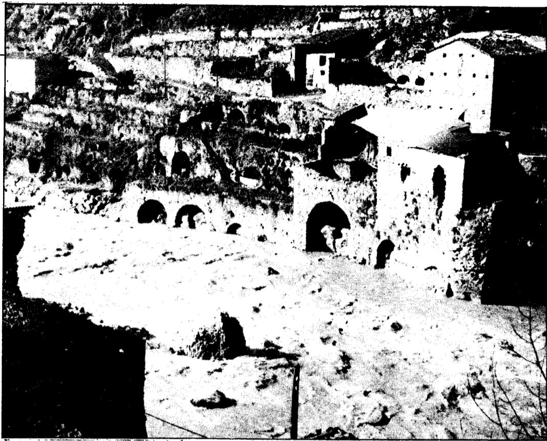
En la foto es pot observar la base on recolza l'històric pont de Pont de Bar, en la construcció del qual morí d'accident el seu promotor i Bisbe d'Urgell Sant Ermengol l'any 1035. La nit del 7 al 8 de novembre fou arrasat per la riuada.
